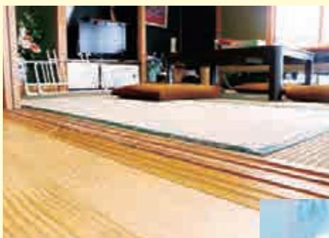
各所の段差にはスロープを設置。
